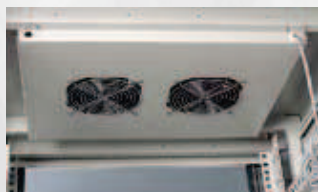
* Rozvaděč je vybaven ventilační jednotkou
